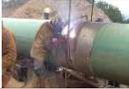
**SOLDADURA DE ARCO AUTO-PROTEGIDO CON NÚCLEO DE FUNDENTE SEMIAUTO-MÁTICA (FCAW-SS) EN PLACA Y TUBERÍA DE PROCESO**
